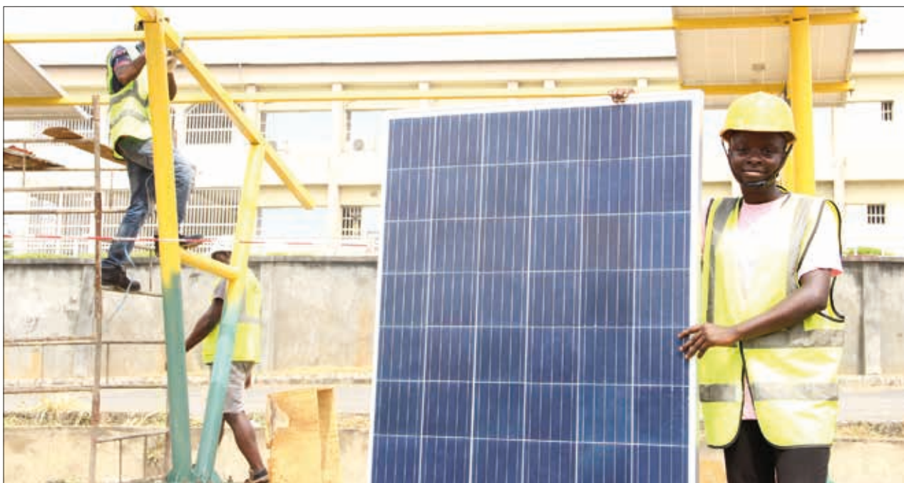
Construction d'un abri solaire photovoltaïque à l'Université d'Ibadan, Nigeria, © Ashdam Solar
